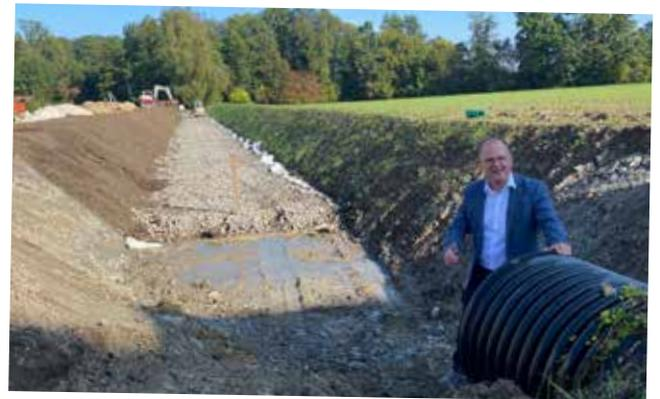
Im Rahmen der Sanierungen der Kanalisation der Fischer-, Quellen- und Leitenstraße wurde ein neues Rückhaltebecken errichtet, das im Falle von Starkregenereignissen für mehr Sicherheit sorgen soll. Daneben wurde das dortige Mischkanalsystem durch ein neues getrenntes System für Regen- und Schmutzwasser ersetzt, was noch mehr Schutz bewerkstelligen soll.
